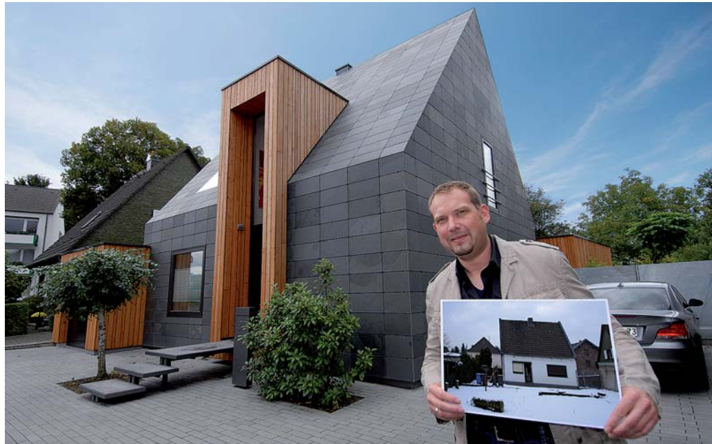
Das Naturprodukt Schiefer erlebt bereits seit einigen Jahren bei Sanierungen und Neubauten seine Renaissance.
