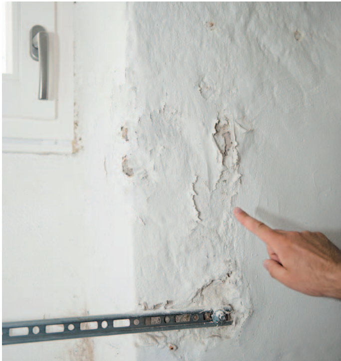
Manchmal fallen Feuchteschäden erst auf den zweiten Blick auf. Foto: ISOTEC GmbH/Andreas Henk
