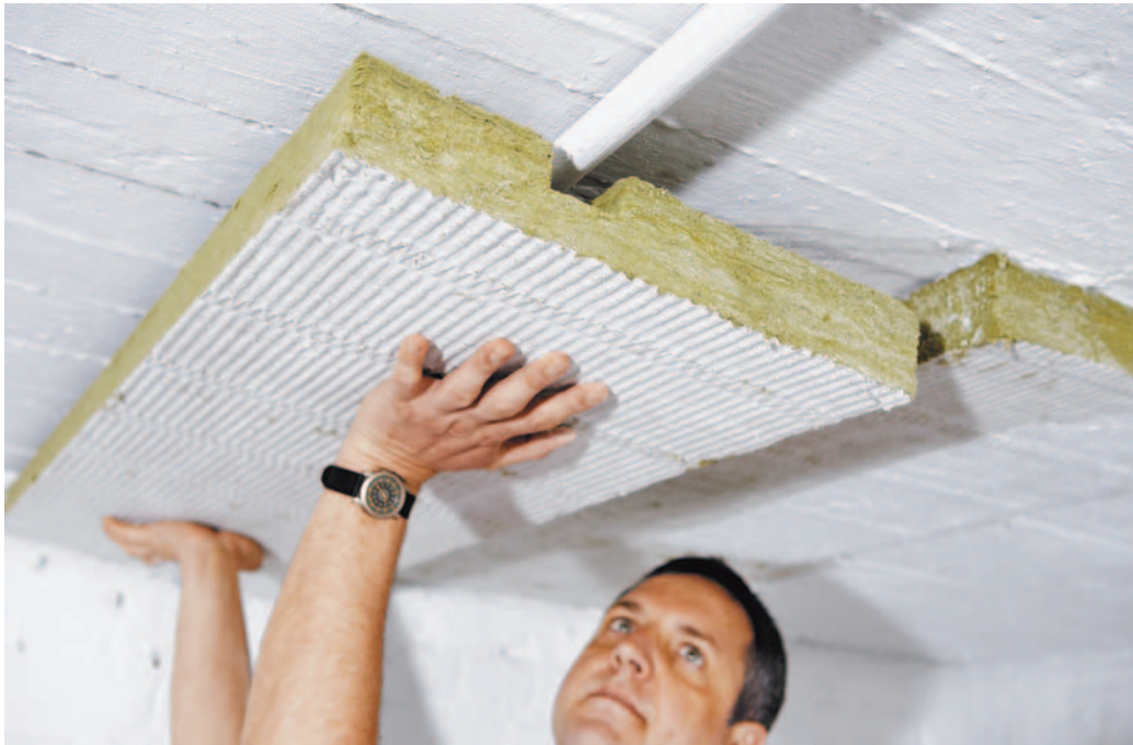
Die Dämmung der Kellerdecke ist eine effektive Maßnahme zur Energieeinsparung.
