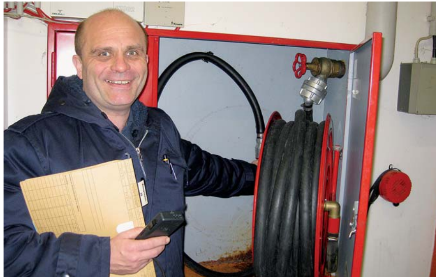
Brandchutzoberinspektor Helge Leefers vom Referat Feuerwehr- und Rettungsdienst überprüft einen Wandhydranten. Foto: Steinbrücker
