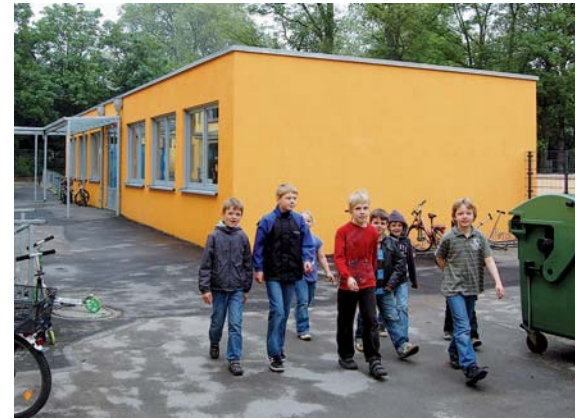
Der neue Anbau der Winrich-von-Kniprode-Grundschule in Baumberg beherbergt zwei Klassenräume für Unterricht und Betreuung. Foto: Breulmann
