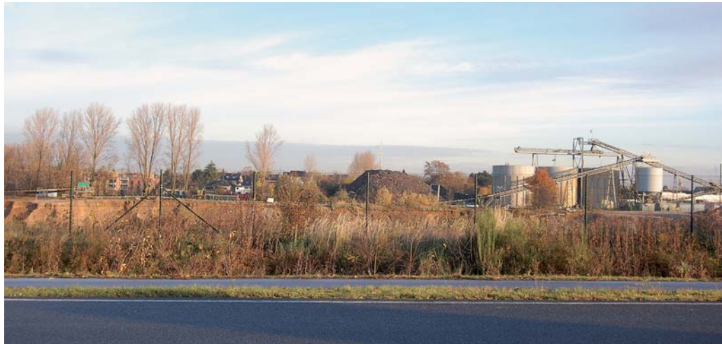
Baustelle Kielsgraben: Der Sportplatz fällt im Sommer nächsten Jahres weg.
