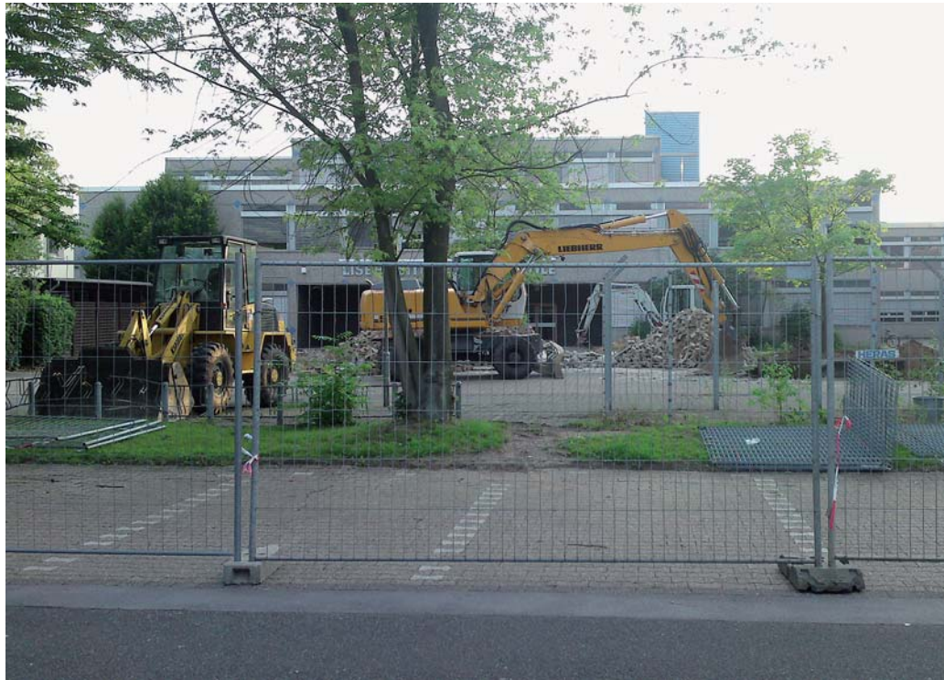
Auch die im August/September 2010 umgebaute Lise-Meitner-Realschule hatte sich beworben – mit einem Projekt zur Nutzung einer Photovoltaikanlage. Foto: Frank Straub
