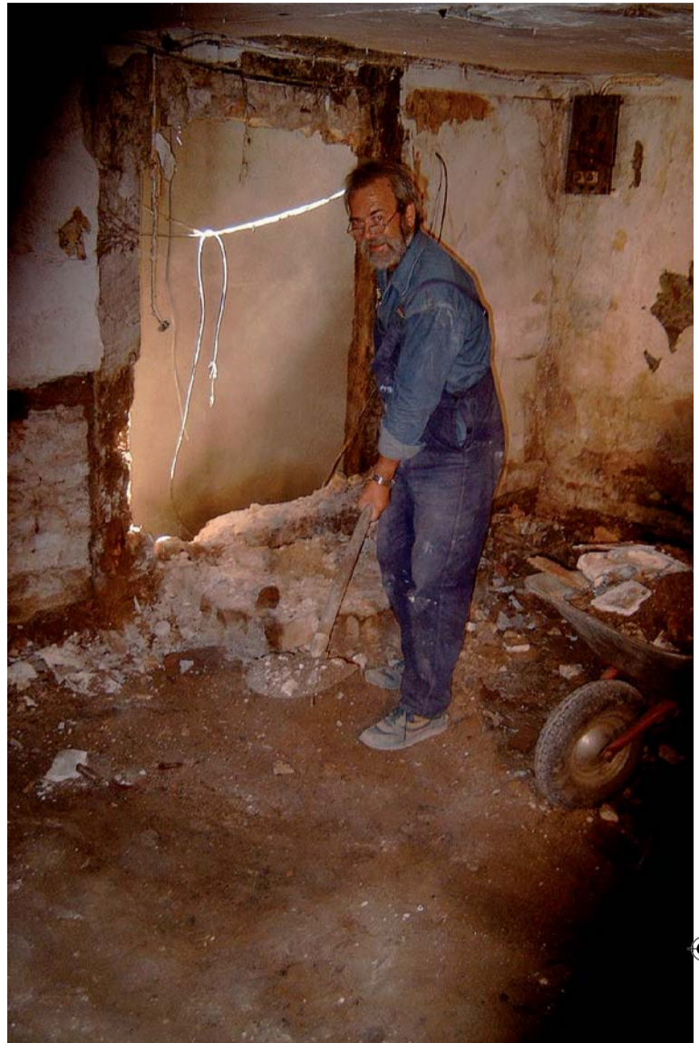
Schwerstarbeit, alleine den Schutt aus dem Haus zu schaffen.
