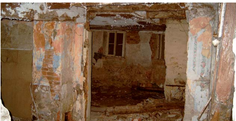
Das Haus war in einem furchterregenden Zustand.
