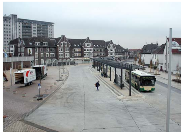
Barrierefrei und elektronisch unterstützt: Die Hälfte der Kosten für den Busbahnhof übernahm der VRR.
