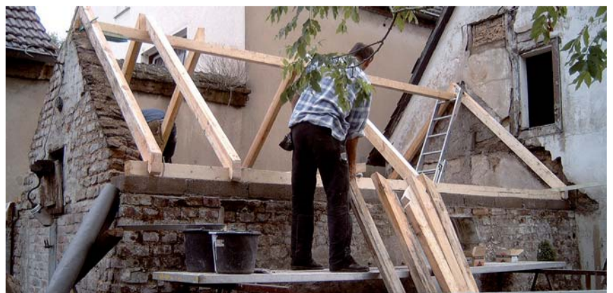
Arbeiten am Dachstuhl: Auch der Anbau wurde von Grund auf saniert.
