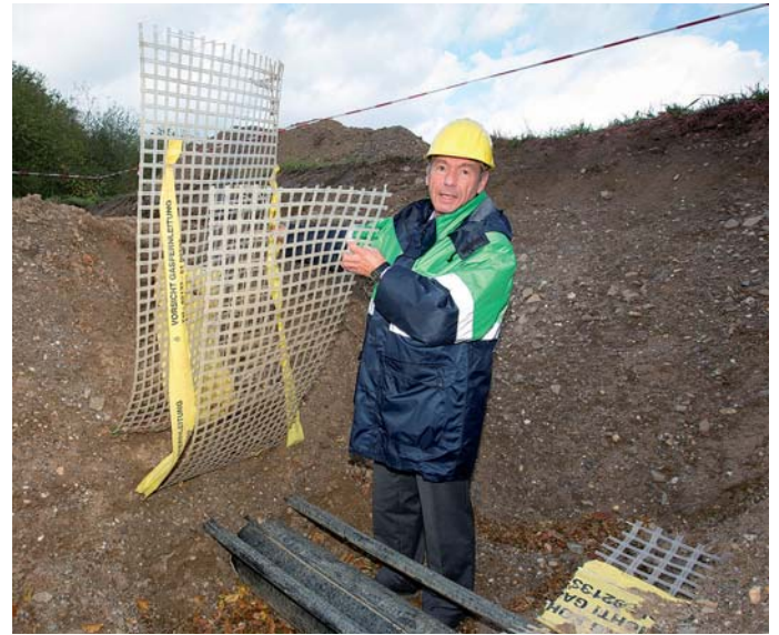
Projektleiter Werner Breuer erläuterte unlängst an einer Teststrecke in Monheim den Aufbau der CO-Pipeline und die installierten Sicherheitseinrichtungen. In den Händen hält Breuer zwei Geo-Grid-Matten, die bei Eingriffen von oben laut BMS eine Warnfunktion haben. Foto: Bayer MaterialScience AG
