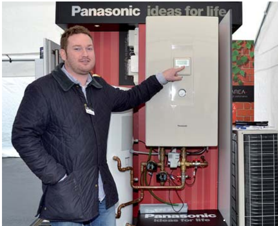
Florian Denecke von der H.W. Denecke GmbH bietet moderne Sanitärtechnik, effiziente Heizungskonzepte und alles fürs Wohlfühlklima.
