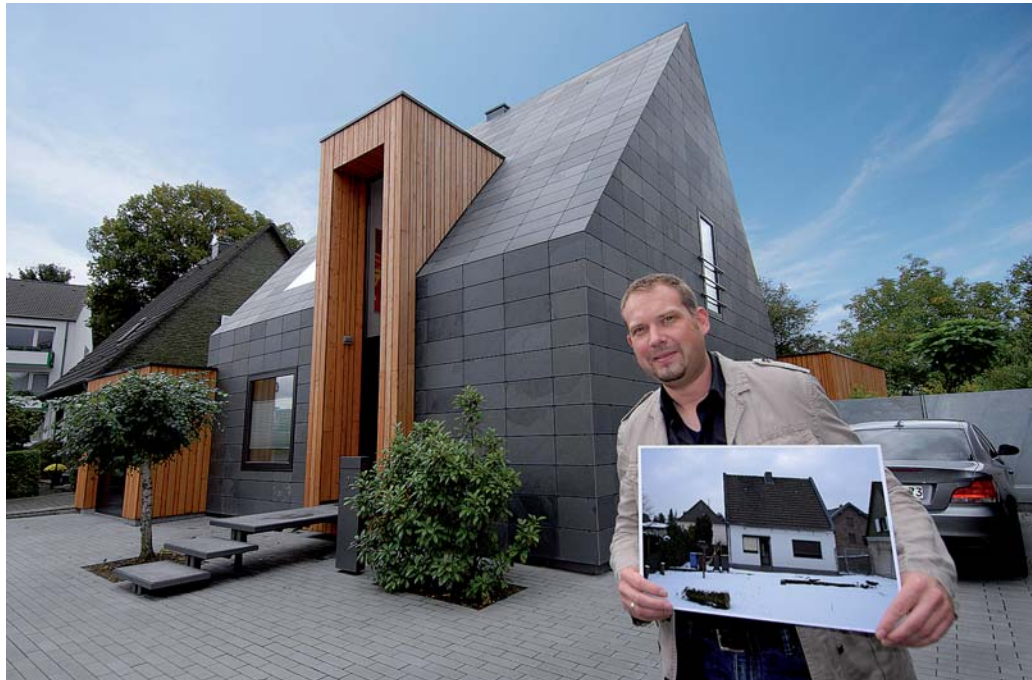
Das Naturprodukt Schiefer erlebt bereits seit einigen Jahren bei Sanierungen und Neubauten seine Renaissance.
