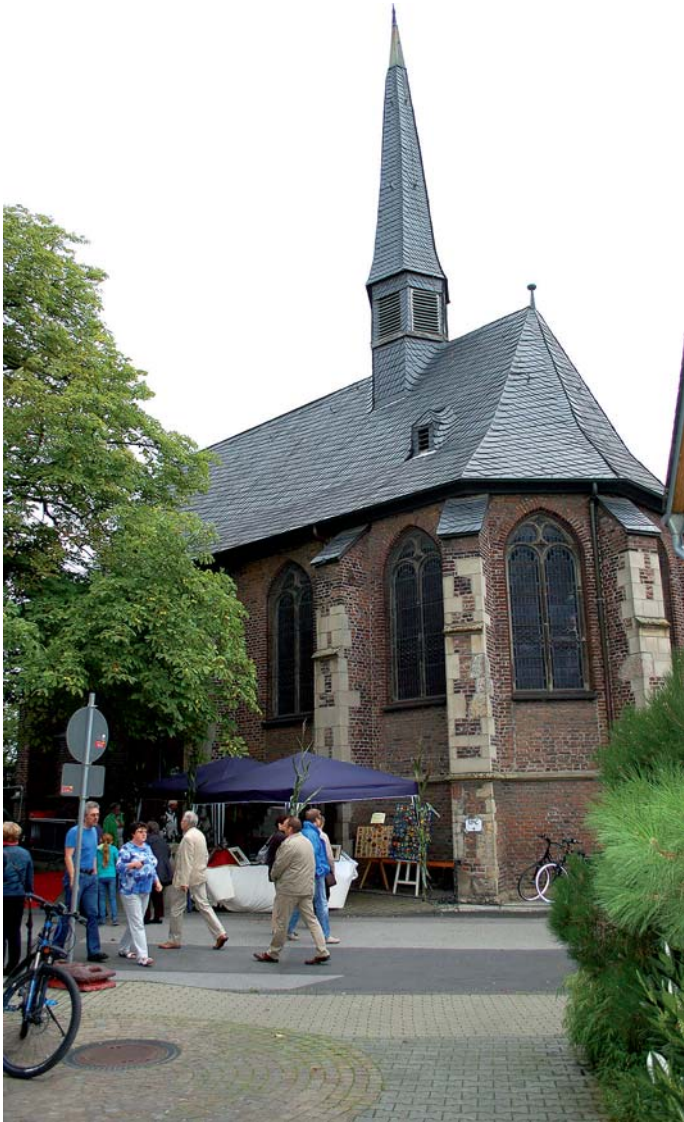
Blick auf die Marienkapelle: Die spätgotische Kapelle wurde im Jahr 1514 aus solidem Stein gebaut und zuletzt 2006 saniert. Fotos (9): Simons
