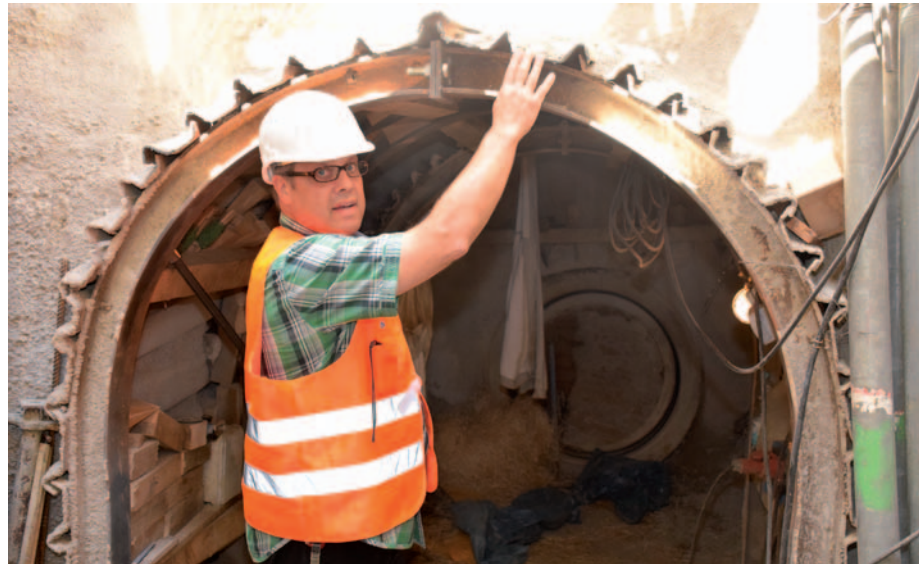
Rainer Fester, im Rathaus federführend in Sachen Kanalbau, erläutert den Ablauf der Arbeiten. Foto: Norbert Jakobs
