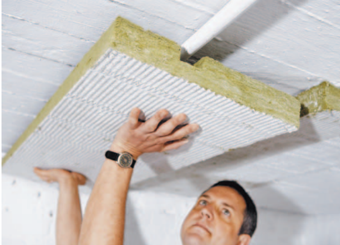
Die Dämmung der Kellerdecke ist eine effektive Maßnahme zur Energieeinsparung. Foto: Fachverband Mineralwolle
