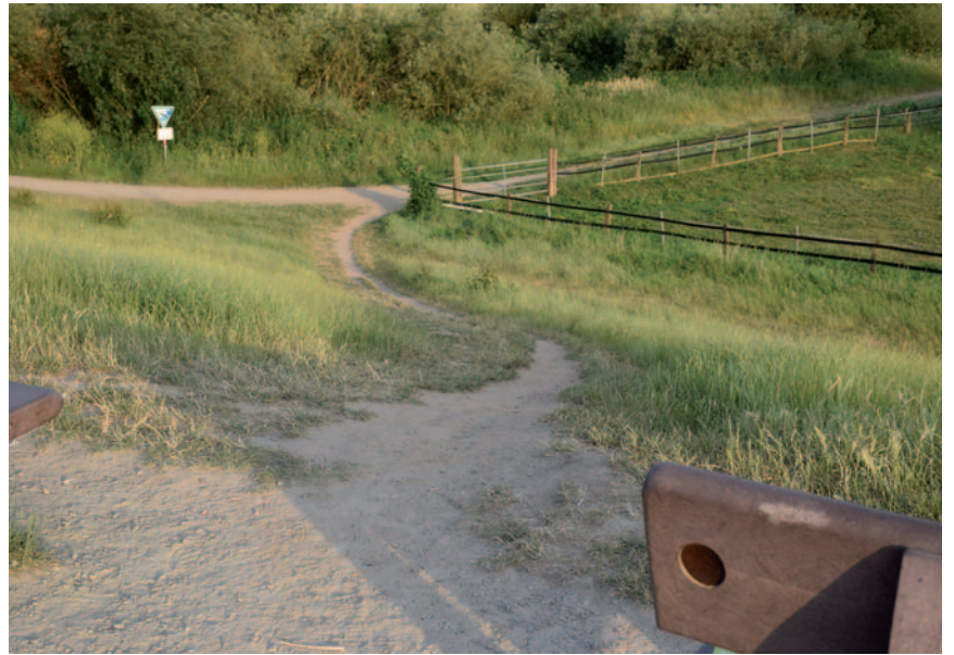
Trampelpfade quer über die Deichböschung, wie hier im Bereich Am Werth gegenüber der Altstadt, erhöhen bei Hochwasser die Erosionsgefahr. Foto: Norbert Jakobs
