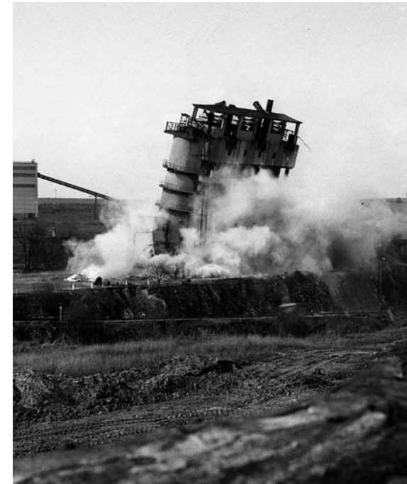
Als der alte Ringschachtofen der Kalksteinwerke Neandertal ausgedient hatte, wurde er in den 1960er Jahren gesprengt. Repros(3): Mikko Schümmelfeder
