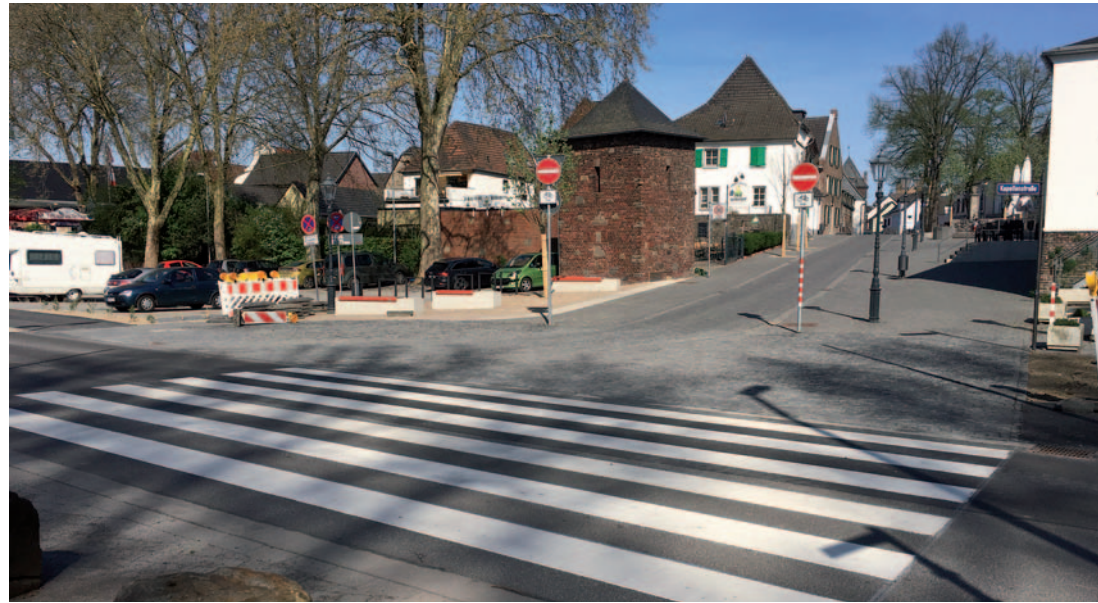
Freie Fahrt für Kinderwagen, Rollatoren und Rollstühle: Der neue Übergang ist barrierefrei und führt bequem und sicher von der Altstadt in den Rheinbogen. Nach fünf Monaten Bauzeit ist der Übergang an der Kapellenstraße jetzt fertiggestellt.
